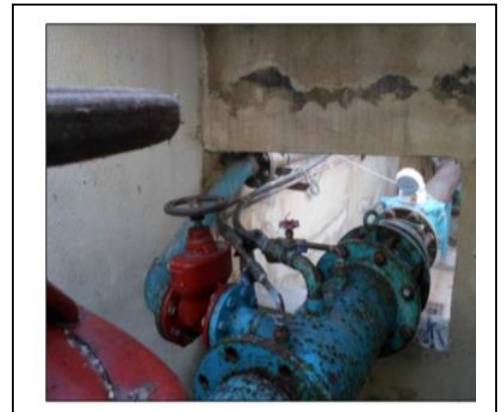
Fig. 4 Vue de la tête de pompage - colonne d'exhaure débitmètre et jeux de vannes (F1)
