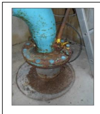
Fig. 4 Vue de la tête de pompage - colonne d'exhaure débitmètre et jeux de vannes (F1)
